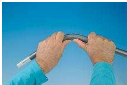
Гибка с помощью внешней гибочной пружины
